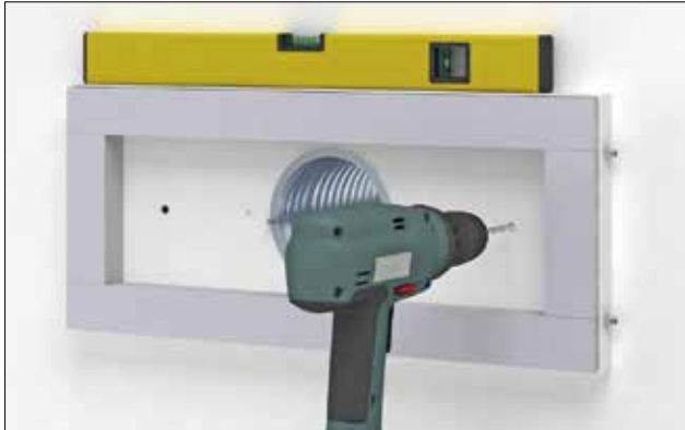
Bild 12 Befestigungslöcher bohren
