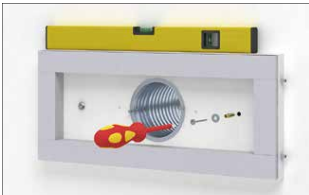
Bild 13 Kunststoffdübel verwenden und Schrauben festziehen
