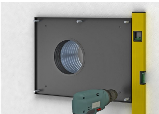
Bild 5: Überströmelement mit 6 Muttern auf Gewindebolzen befestigen
