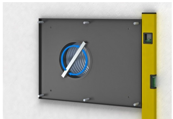
Bild 4: Kunststoffdübel verwenden und Schrauben eindrehen
