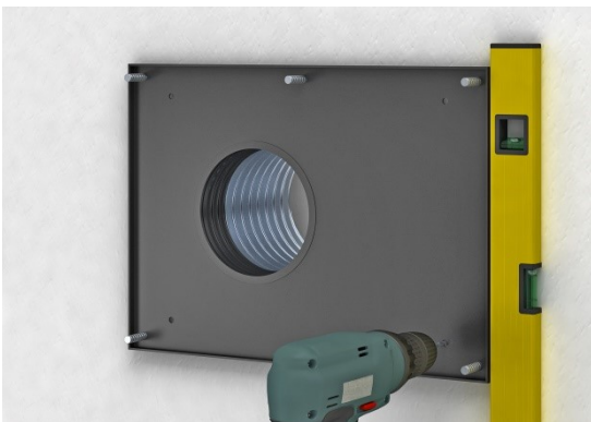
Bild 5: Überströmelement mit 6 Muttern auf Gewindebolzen befestigen
