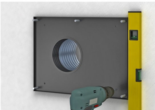
Bild 5: Überströmelement mit 6 Muttern auf Gewindebolzen befestigen
